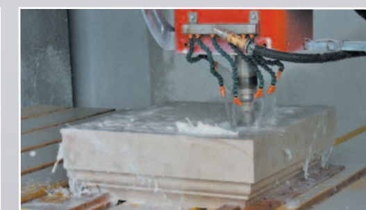
11. Realizzazione lavelli con mole da scasso Execution of wash-basins with diamond tools Réalisation d'éviers avec meule de décaissé Ausführung von Waschbecken mit Diamantwerkzeugen
